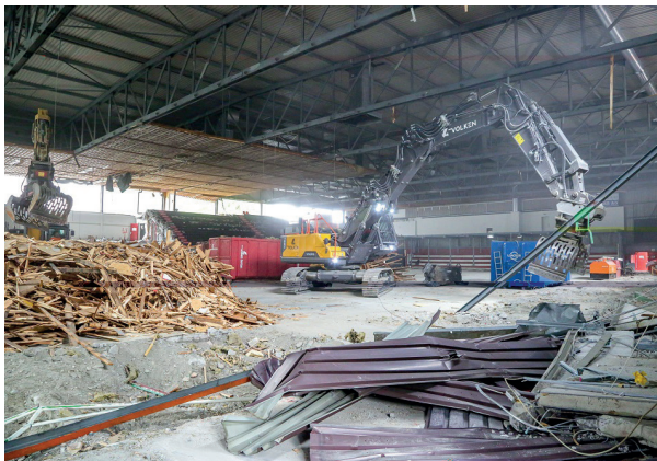
Rückbau der alten Halle
